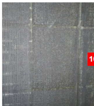
コンデンサ部のドロドロ汚れ 空気が通らない
